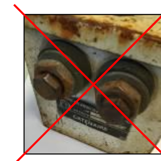
Mauvais : vis oxydées
